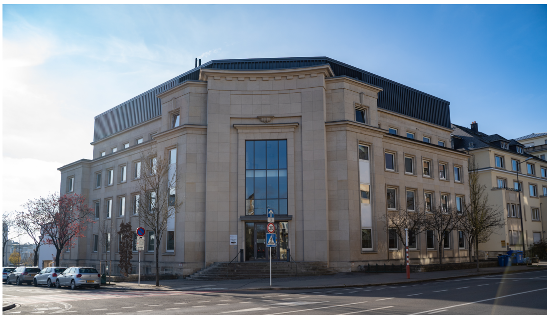
Photo du bâtiment de la direction
