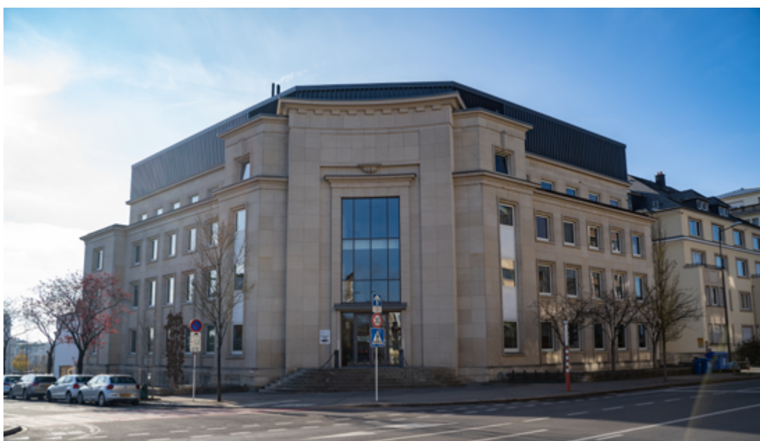
Photo du bâtiment de la direction
